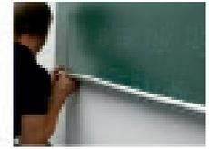
Durch hoch- bzw. herunterdrücken der Kederprofile wird das Gewebe gespannt.
